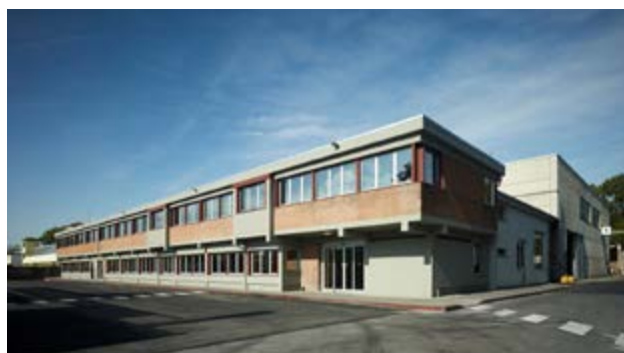
L'edificio del nuovo laboratorio di cui il gruppo CM Manzoni si è dotato di recente. The building of the new laboratory, which the CM Manzoni group has recently equipped.
